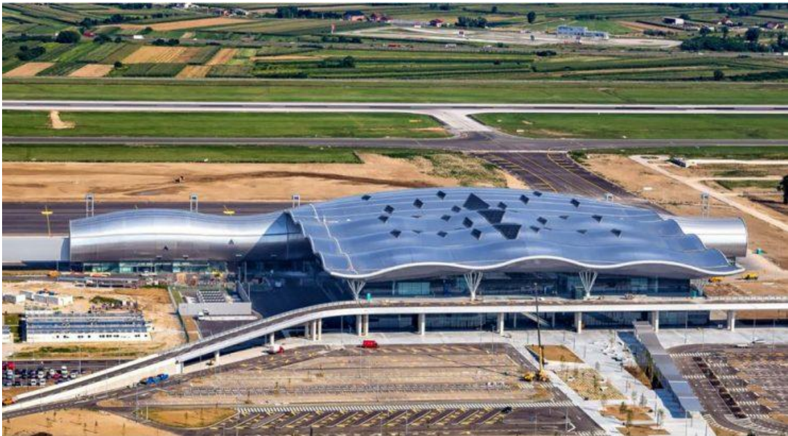
Figura 2 - Foto del nuovo terminal "Franjo Tudjman" dell'aeroporto di Zagabria, finanziato in parte dal fondo Marguerite I
