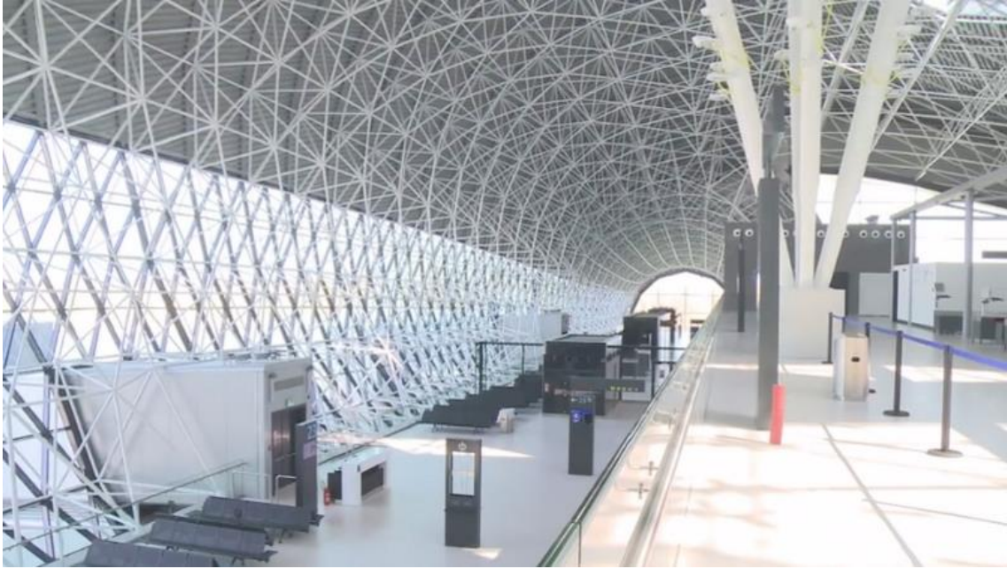
Figura 1 - Foto dell'interno del nuovo terminal "Franjo Tudjman" dell'aeroporto di Zagabria, finanziato in parte dal fondo Marguerite I
