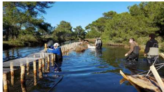
Mise en place des grilles gabions
