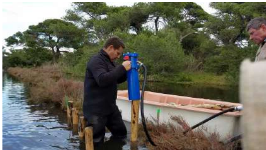
Conficcamento palo pneumatico
