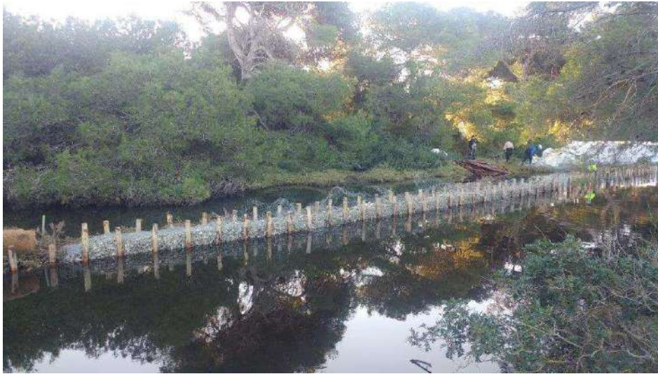
Photo de pose de gabions faits de poches à huîtres
