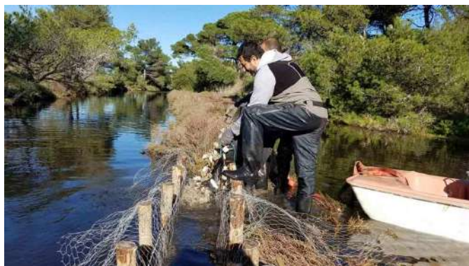
Remplissage des fascines avec des coquilles d'huîtres
