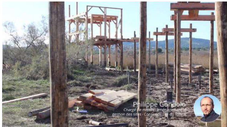
Mise en place des pieux en eucalyptus
