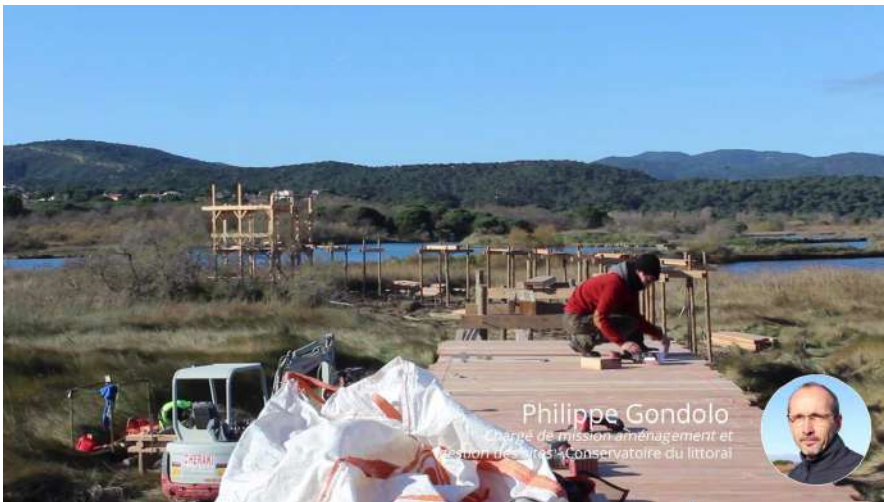
Réalisation du platelage de cheminement
