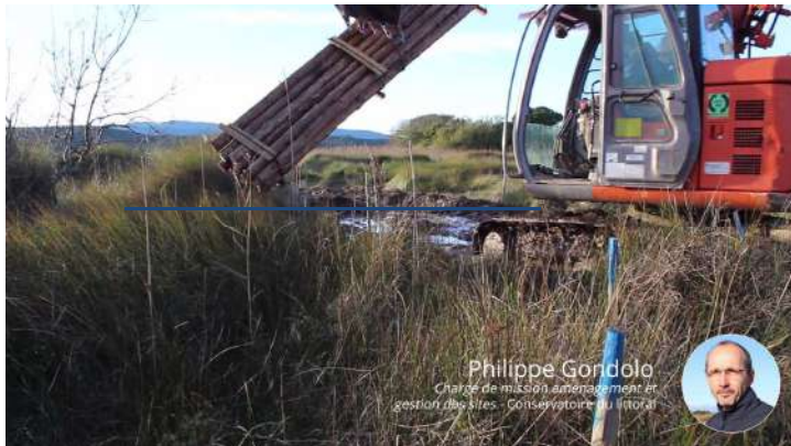
Preparazione del cantiere
