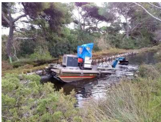
Travaux de curage en Mobitrac pour rehausser la berge
