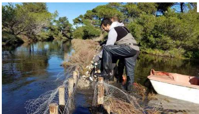
Riempimento delle fascine con gusci di ostriche
