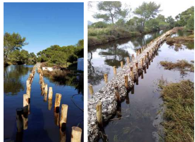
Réalisation d'une fascine à huîtres
