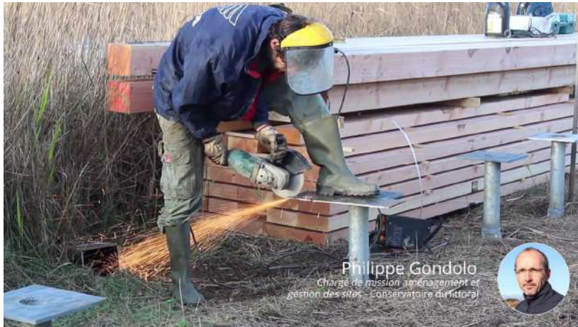
Mise en place des fondations
