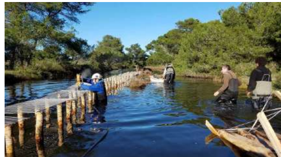
Collocazione delle griglie dei gabbioni
