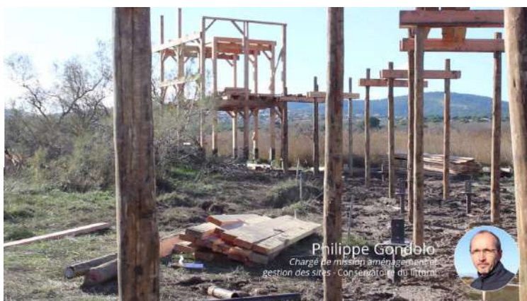
Collocazione dei pali in eucalipto
