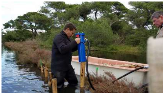
Enfonce pieux pneumatique
