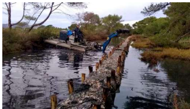
Le Mobitrac à l'œuvre pour curer le canal
