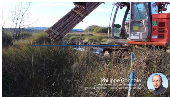
Préparation du chantier
