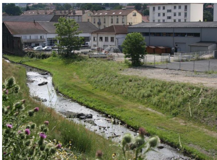
Etat actuel du fleuve Ondaine, après l'intervention de réouverture et réaménagement de la rivière
