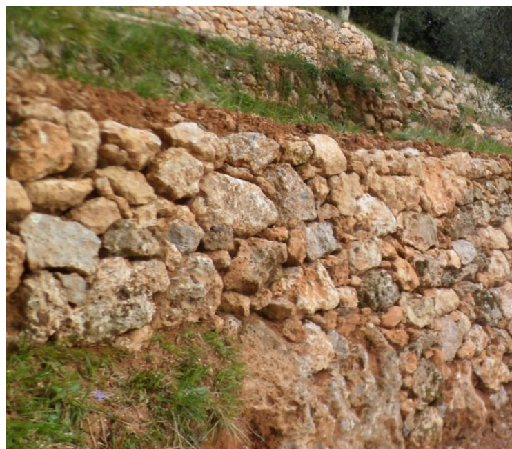
Détail d'un système de terrasses toscanes
