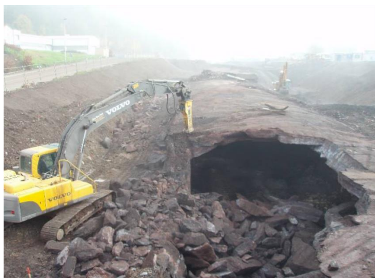
Opérations d'élimination de la couverture fluviale Ondaine, Chambon Feugerolles
