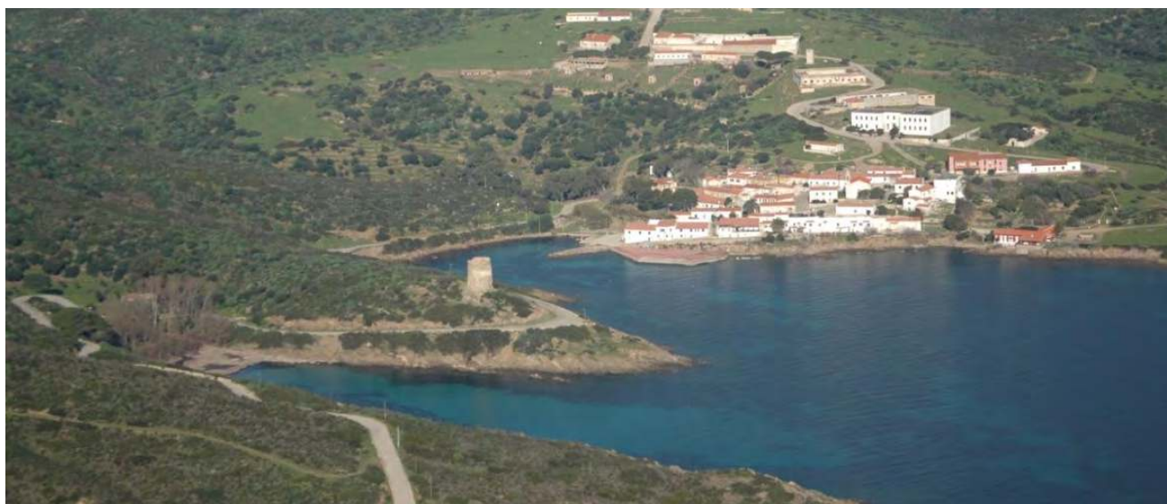
Fig. 1 – Le village de Cala d'Oliva et la tour qui ferme la crique touchée par les interventions.
