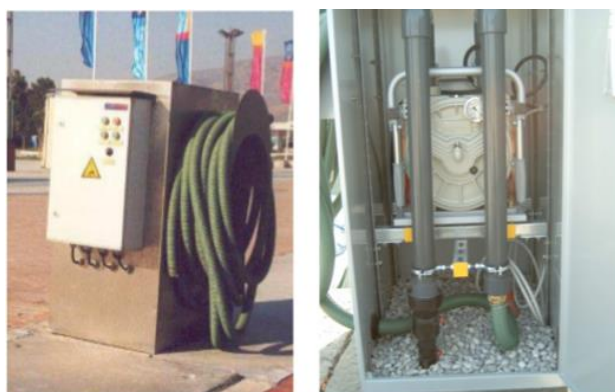
Figura 1. Colonnina per l'aspirazione dei rifiuti liquidi e dettaglio della pompa peristaltica
