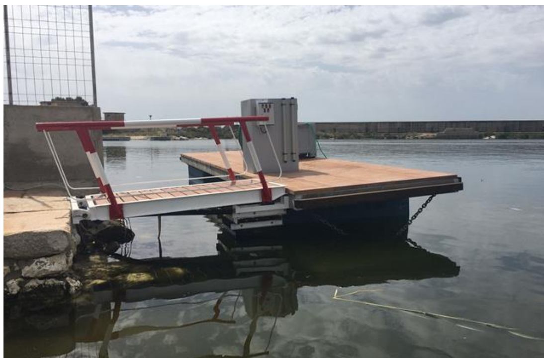
Figura 2. Area attrezzata per l'aspirazione delle acque di sentina nel porto di Cagliari
