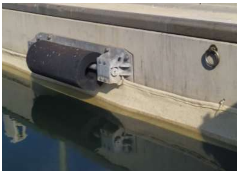
Figura 4. Dettaglio installazione banner sotto i parabordi
