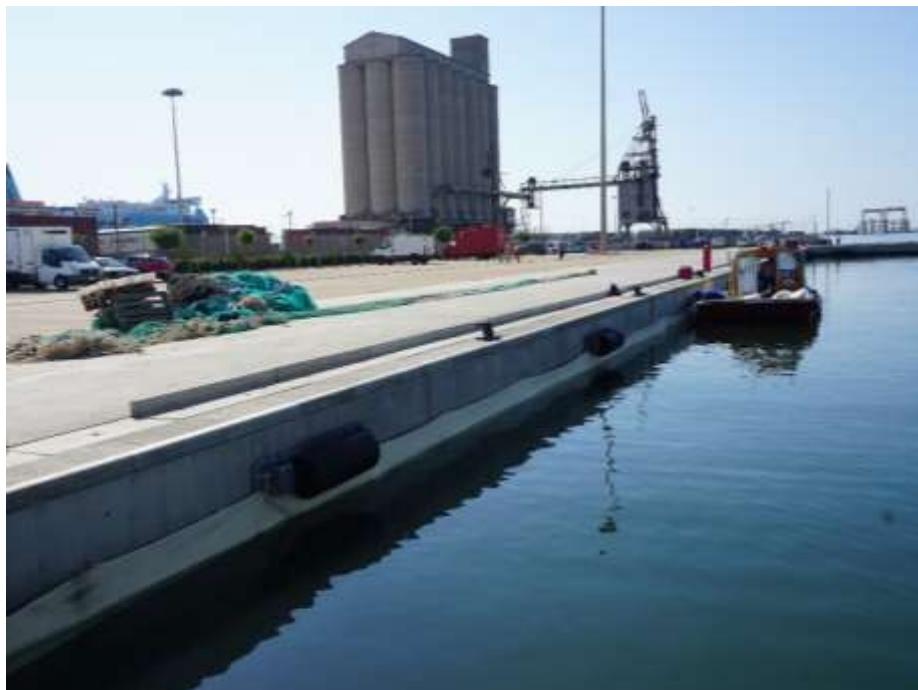
Figura 3. Installazione dei banner lungo una banchina
