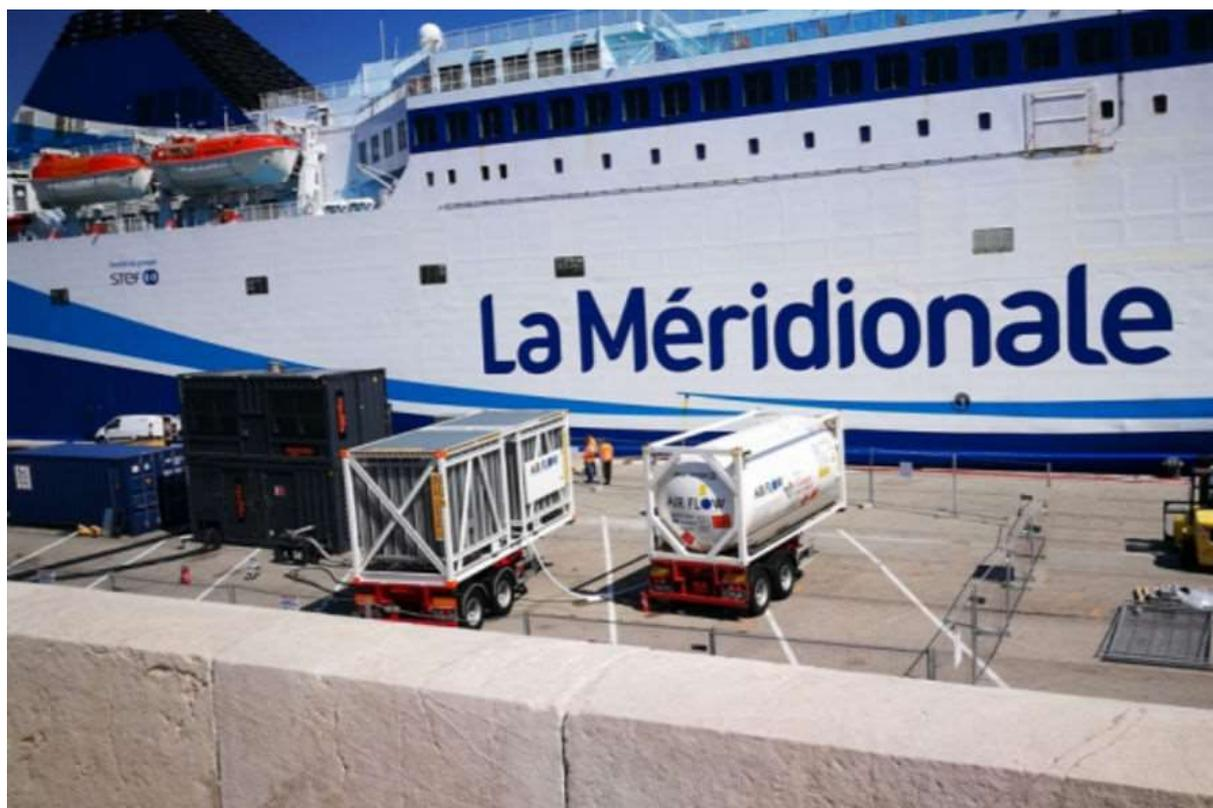
*Figure 11 : Alimentation électrique d'un navire à quai sur le port d'Ajaccio*
