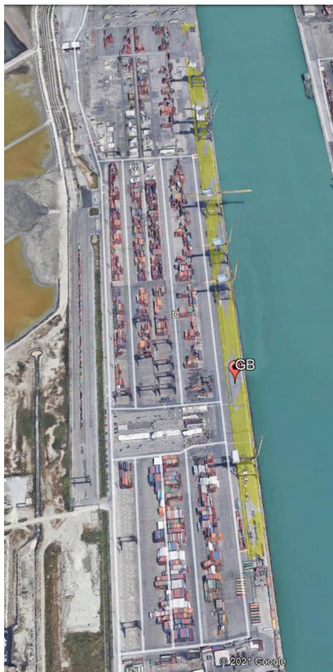
FIGURA 5: AREA DI LAVORO GRU DA BANCHINA
