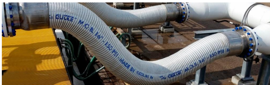
Figura 33. Tubi flessibili criogenici: tecnologia Gutterling
