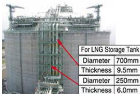
Figura 30. Sistema di piping per il GNL: design con impiego di tecnologia Invar
