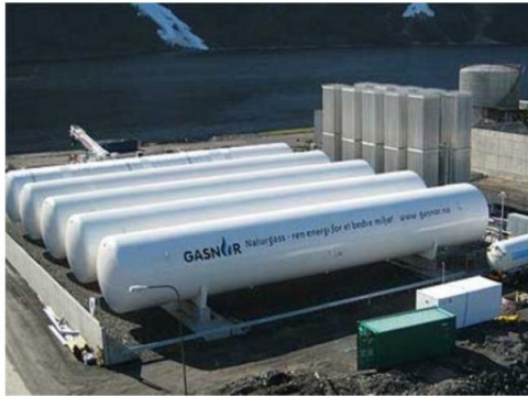
Figure 10 Exemples de réservoirs sous pression (sx) et atmosphériques (dx) (9)
