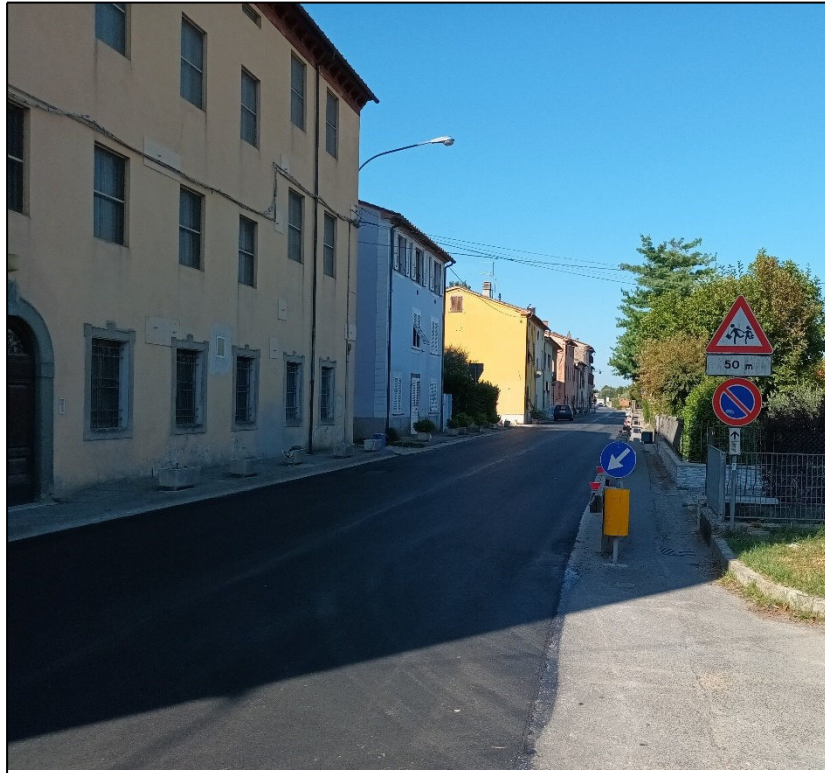
Figure 4 - Via di Carràia, zone de démonstration après la pose de l'asphalte insonorisant. A droite sur la photo, l'emplacement de l'école principale bénéficiant de l'intervention.
