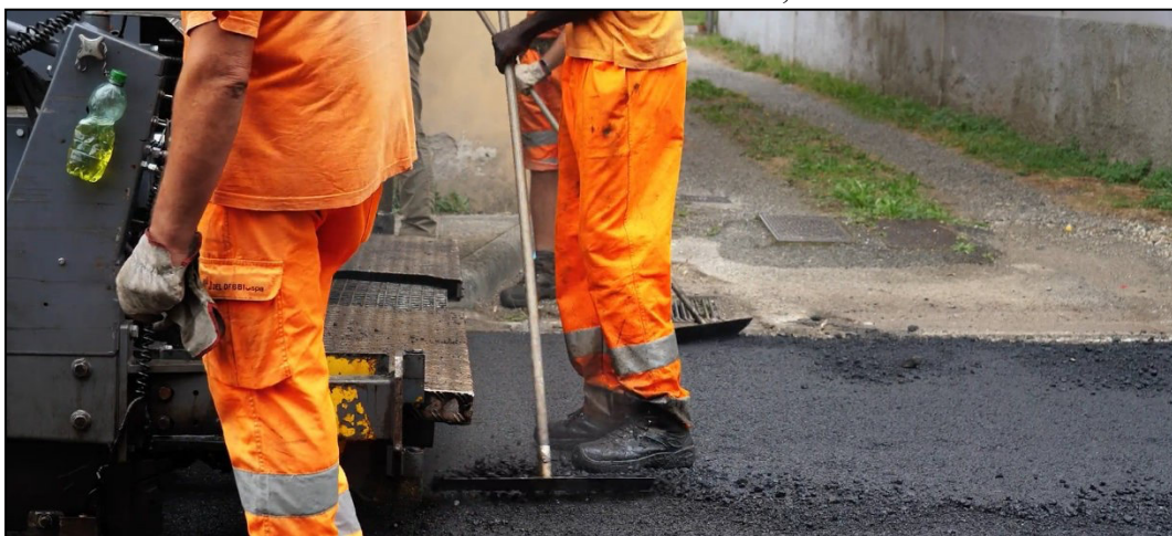
Figure 3 Via di Carraia, zone de démonstration pendant la pose de l'enrobé phonique.
