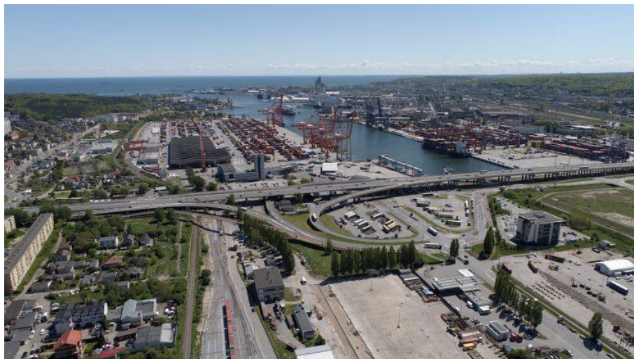
Figure 14 - Infrastructure routière dans le port de Gdynia
