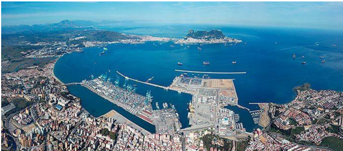
Figure 42 - Vue aérienne du port d'Algéiras (Source: Safety4Sea)
