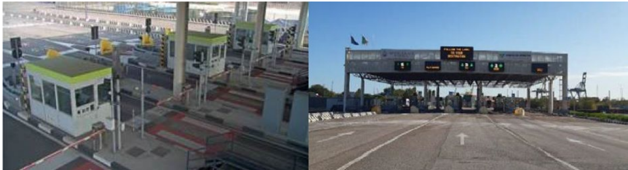
Figure 8 - Système de portes automatisées (AGS) au port de Venise
