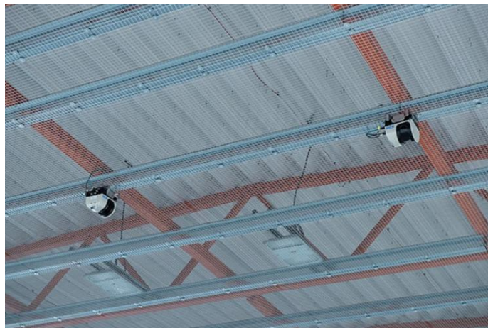
Figure 35 - Capteurs d'identification du véhicule (hauteur, largeur et longueur du véhicule)
