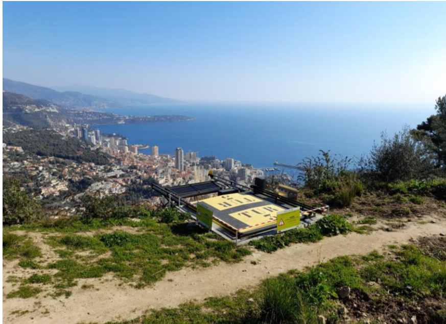
Trappe de cuve pour HBE (vue sur Monaco)
