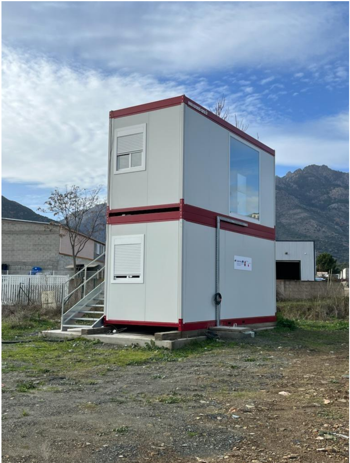
Foto16. Torre di controllo
