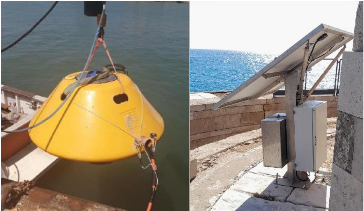
Instrumentation installée sur la digue du port de Livourne.
