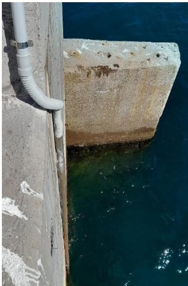
Cavo di trasmissione dati e alimentazione.
