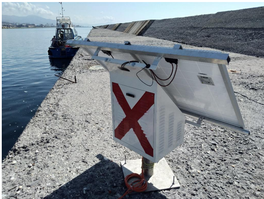
Stazione 4 presso l'ingresso di ponte del Canale di Calma dell'Aeroporto.
