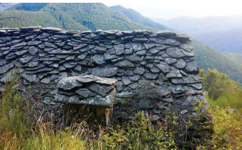
Fig. 12 Alpage de Boiana, détail du toit en dalles de grès avec la cheminée
