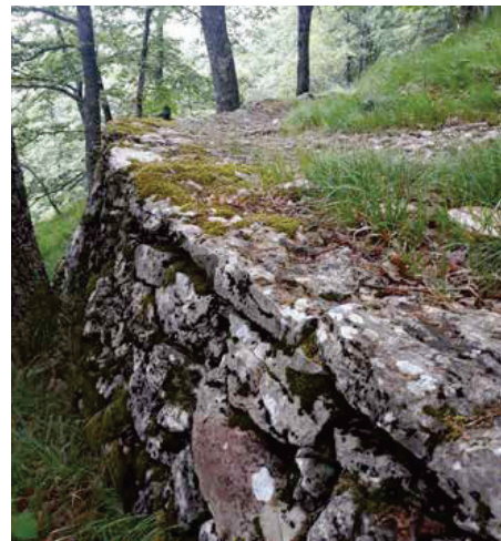
Fig. 54 Route de l'alpage de Corfino en direction de Campaiana, détail du ballast en pierre sèche soutenant la chaussée à proximité d'un virage
