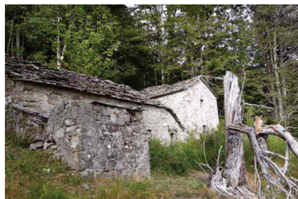
Fig. 26 Alpage Il Cipollino: étable (premier étage) et habitation
