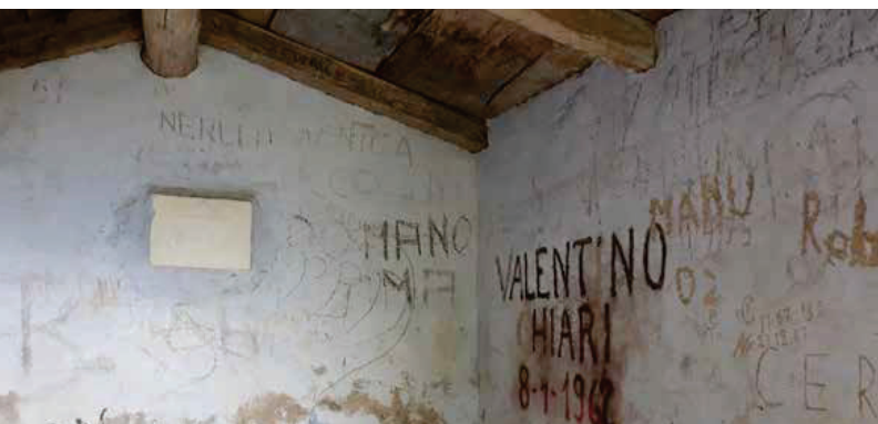
Fig. 53 Intérieur de la petite maestaine montrée dans la figure précédente avec une plaque en marbre et divers graffitis de bergers et de voyageurs sur les murs
