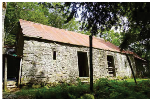
Fig. 25 Le Coste, bergerie dont le toit en tôle a remplacé le toit d'origine en paille de seigle
