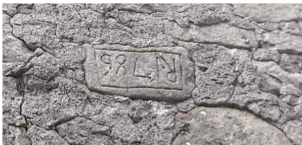
Fig. 28 Quartiana, date 1786 précédée de l'initiale R murée à l'envers dans la façade de la maison
