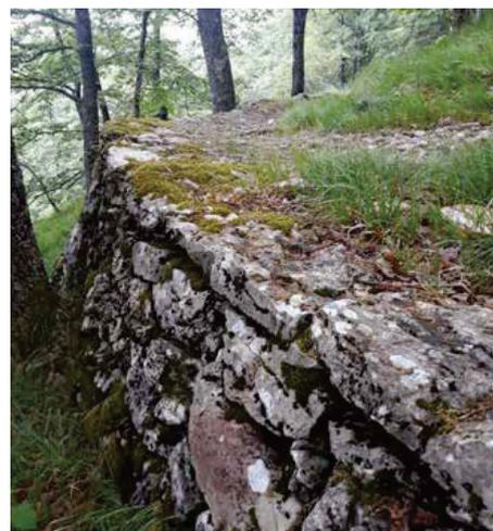
Fig. 54 La via dell'alpe di Corfino verso Campaiana, particolare della massicciata a secco di sostegno alla carreggiata nei pressi di una curva.
