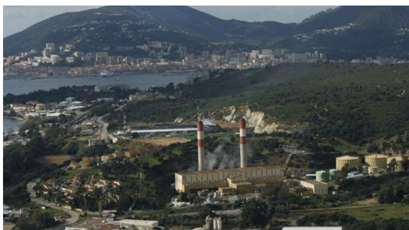
Figura 2: Centrale termica di Vazio
