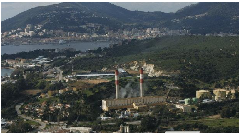
Figure 2 : Centrale thermique de Vaggio
