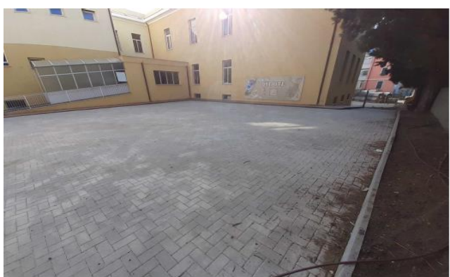
Figure 9,10: Pavimentazione drenante presso Scuola Elementare "Don Peluffo" Figure 9,10 : Revêtement drainant dans la cour de l'école primaire "Don Peluffo"
