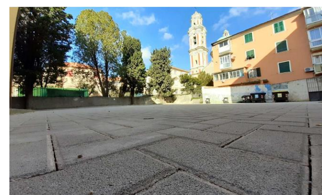
Figure 9,10: Pavimentazione drenante presso Scuola Elementare "Don Peluffo" Figure 9,10 : Revêtement drainant dans la cour de l'école primaire "Don Peluffo"
