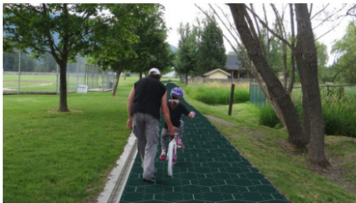
exemple de piste cyclable solaire
