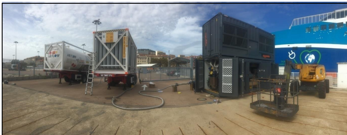
Figura 5.5.5.2. Stazione GNL per il collegamento elettrico.
