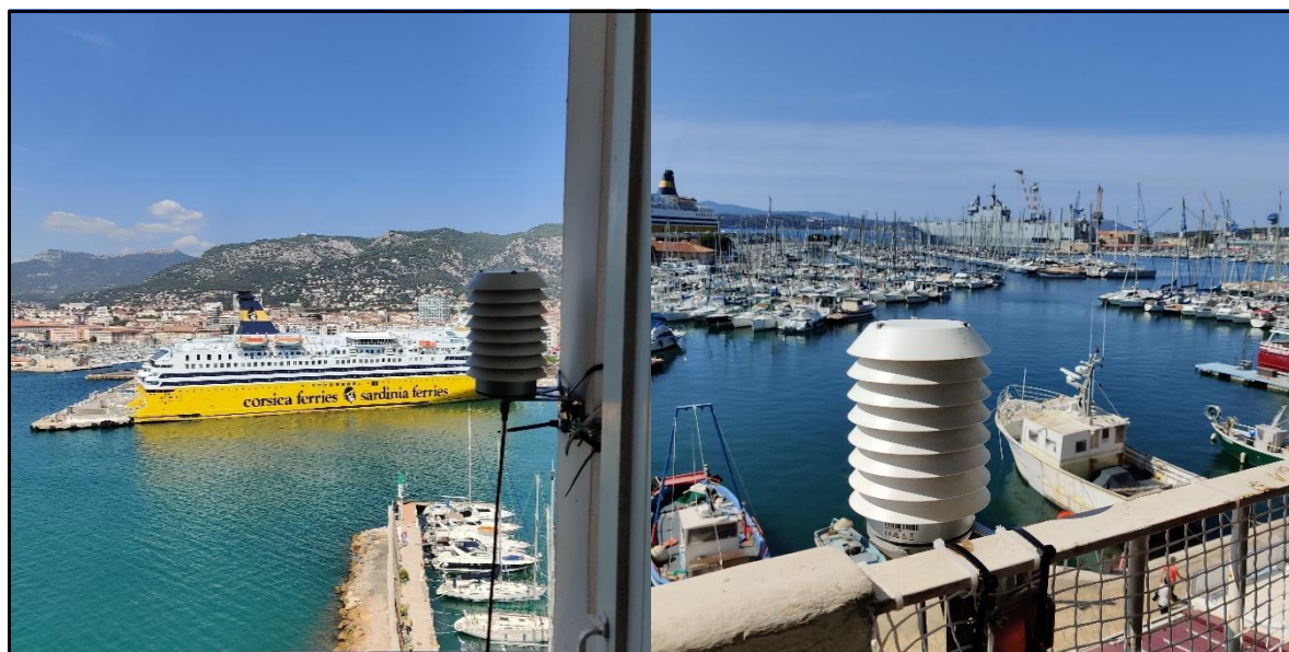
Figura 5.5.4.4. Esempi di foto di installazioni di microsensori presso i residenti locali intorno al porto di Tolone.
