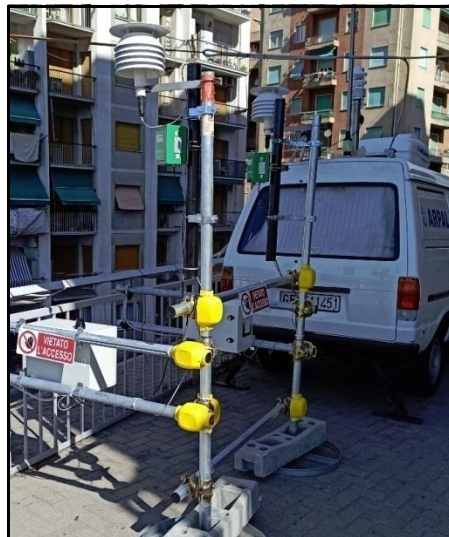
Figura 5.4.1.4. Smart sensor posizionati presso sito di San Teodoro.
