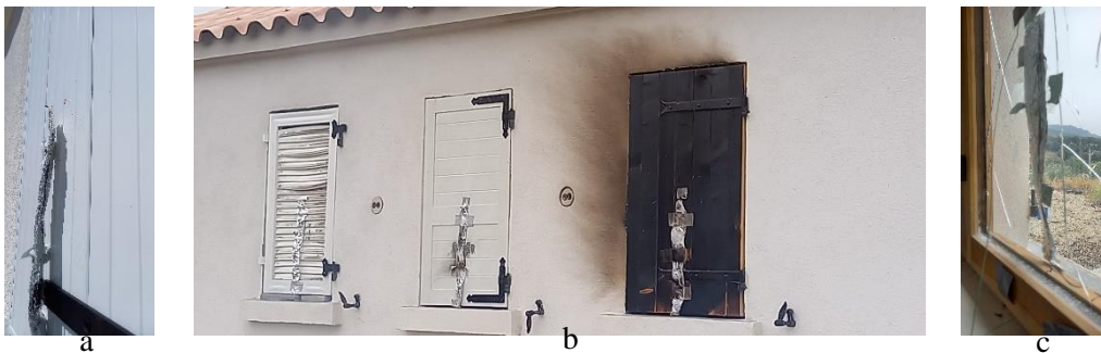
Figure 14 : Dégâts observés avec une haie de a) 6 m × 1 m × 1 m - b et c) 6 m × 2 m × 1 m
