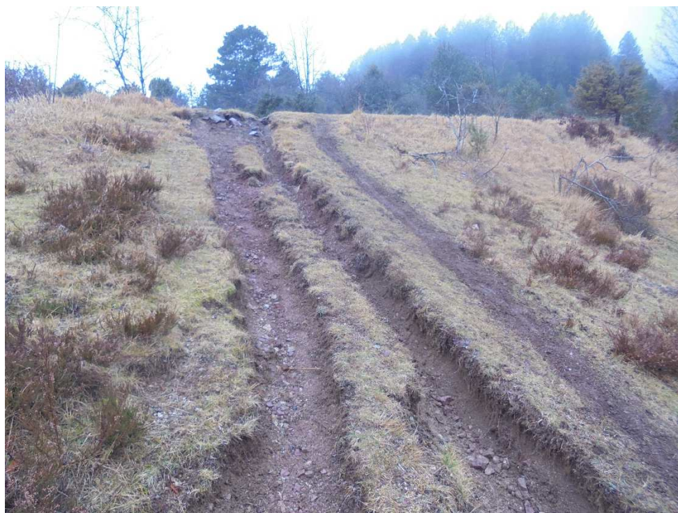
Figure 4: Route d'accès avant l'intervention
