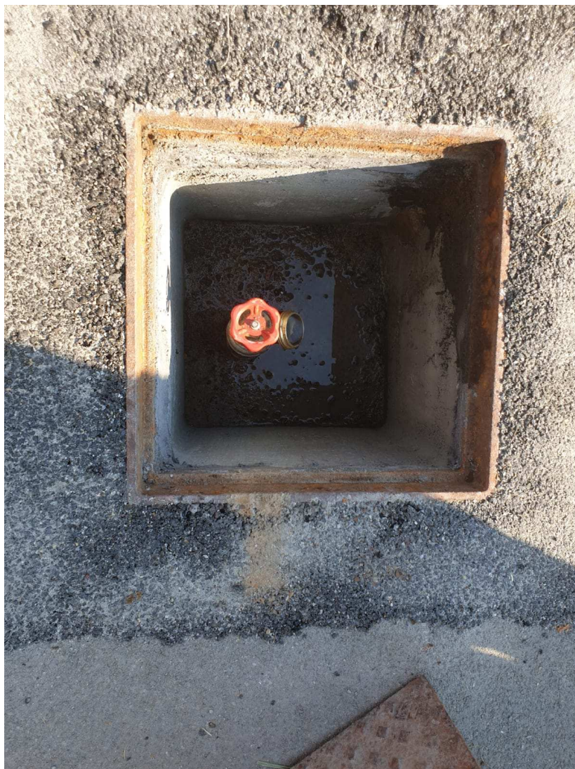
Figure 9: Nouvelle bouche d'incendie construite
