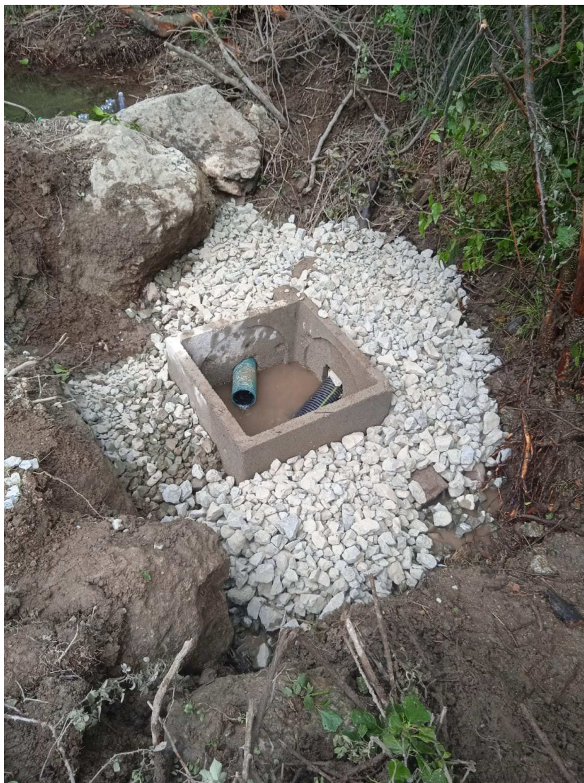
Figura 7: Sistemazione del pozzetto di presa
