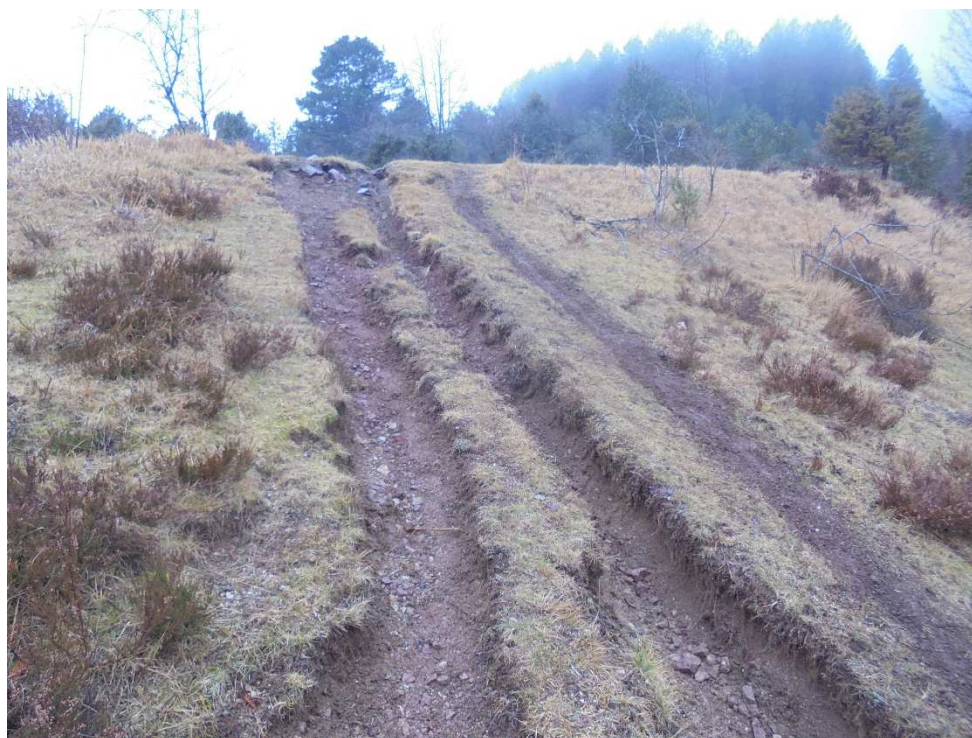
Figura 4: Strada di accesso prima dell'intervento
