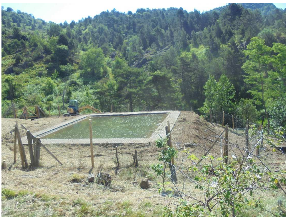
Figure 3: réservoir après l'intervention
