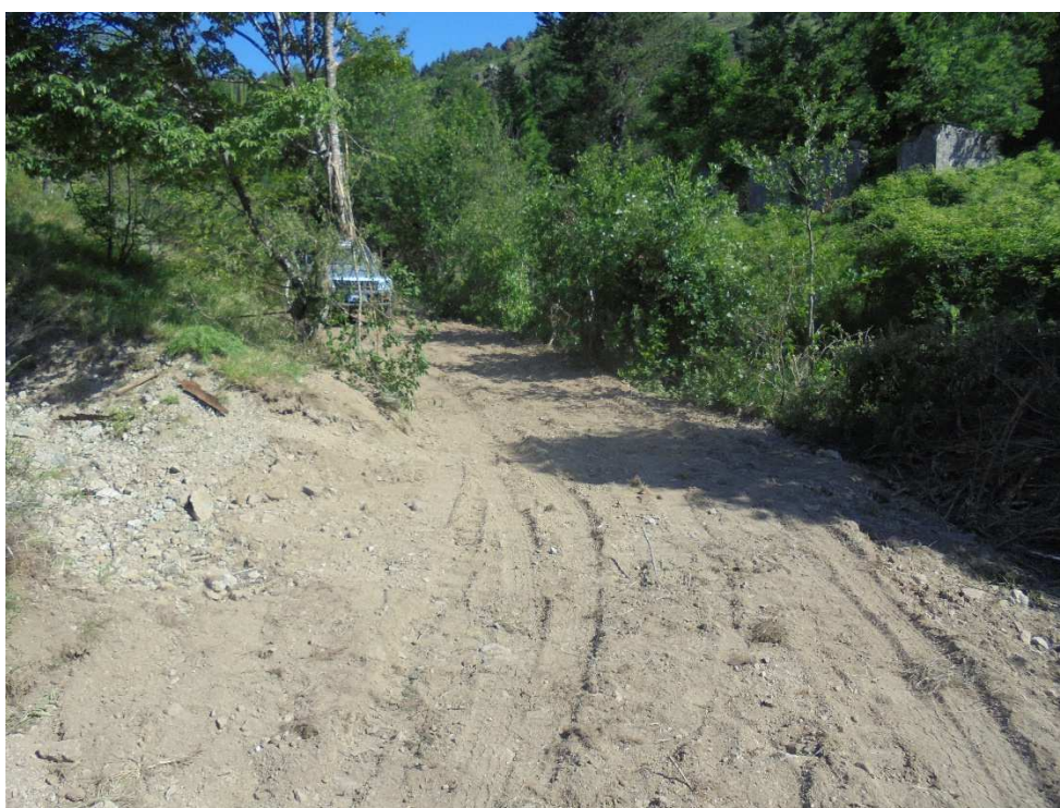
Figure 5: Route d'accès après l'intervention
