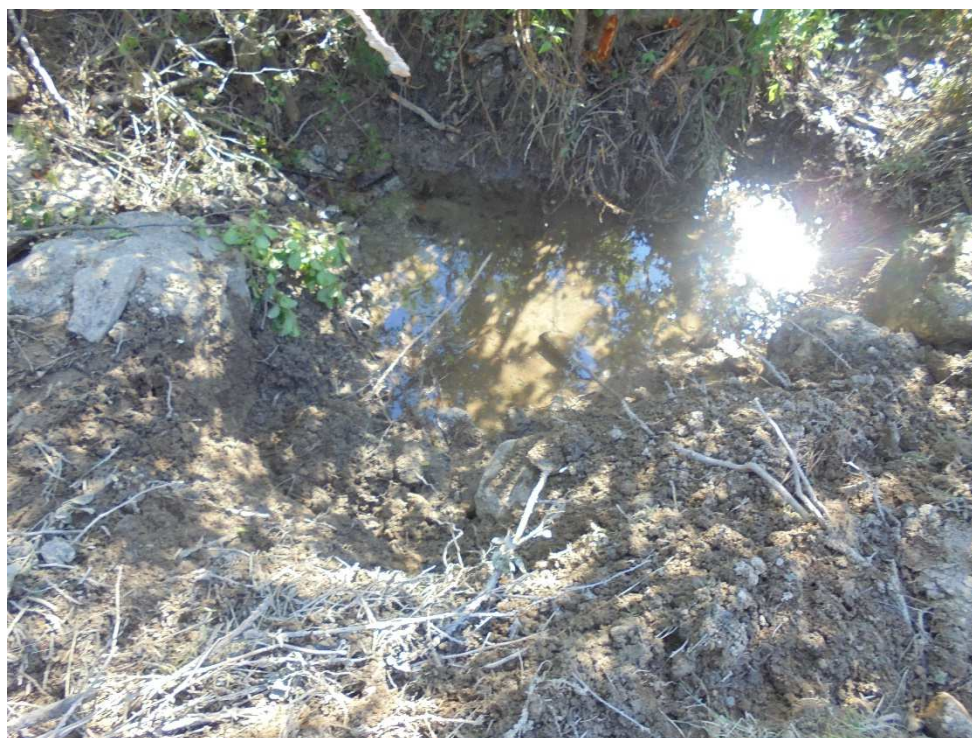
Figure 6: La zone du puisard avant l'installation
