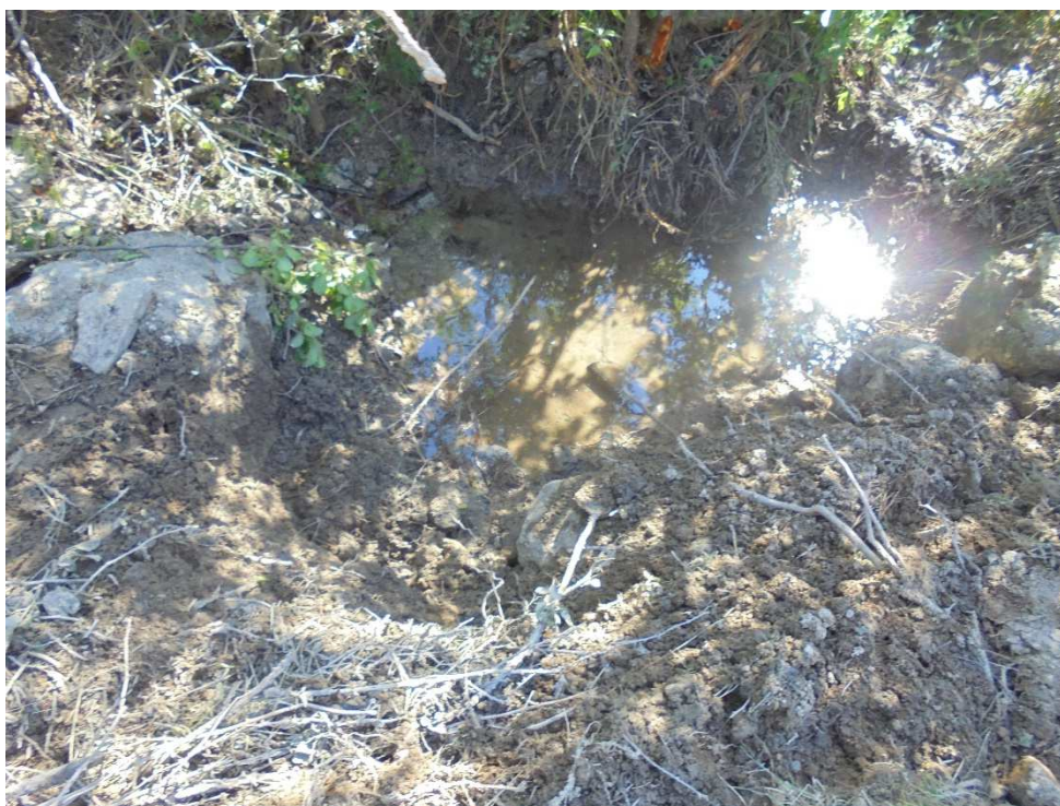
Figura 6: Zona del pozzetto di presa prima della sistemazione
