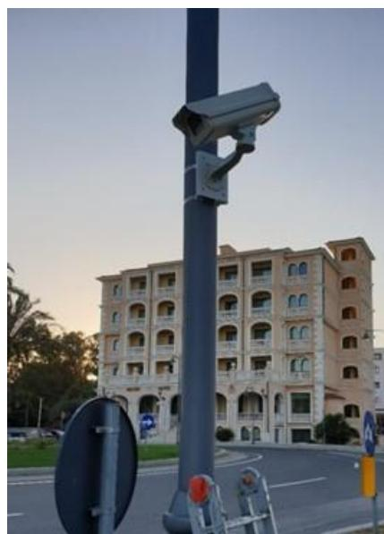
Figura 12. Dispositivo di rilevamento del traffico veicolare
