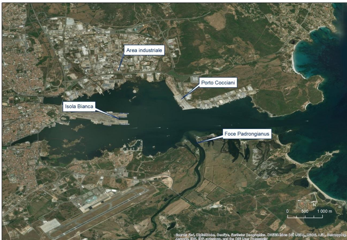
Fig.3 - Vue d'ensemble du port d'Olbia
