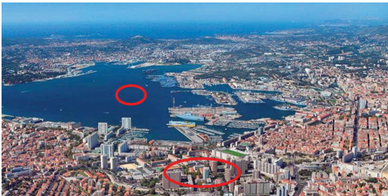
Immagine 14: Foto/Rendering delle aree per il bunkering e lo stoccaggio del GNL Porto di Tolone
