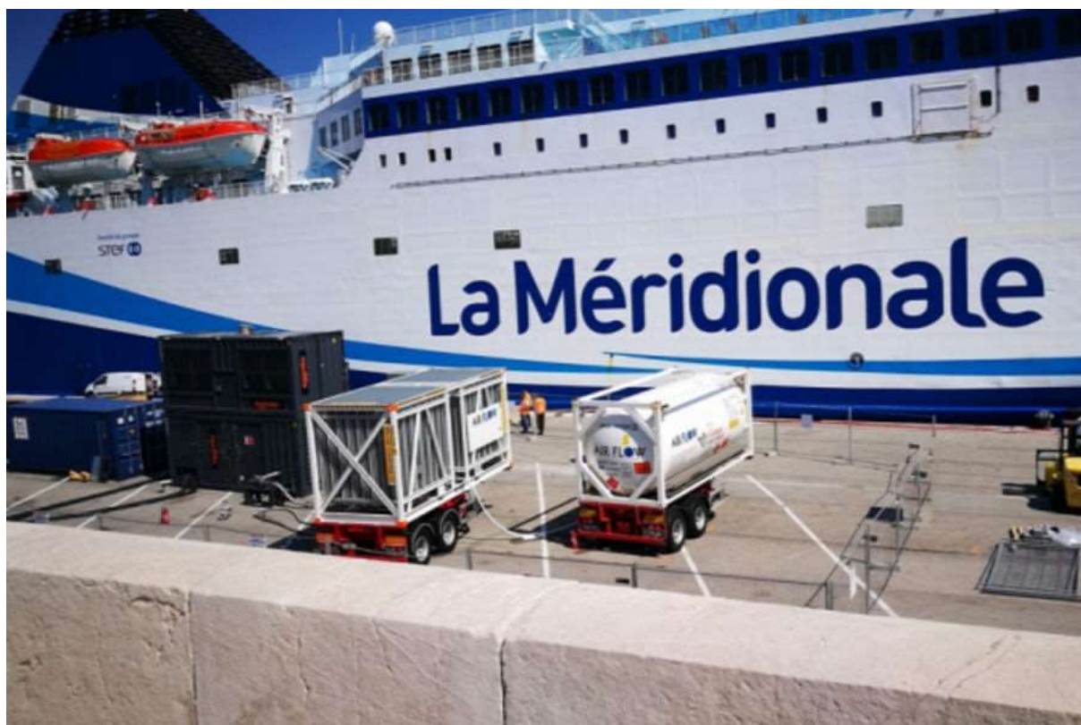
Foto 11: Alimentazione elettrica di una nave nel porto di Ajaccio
