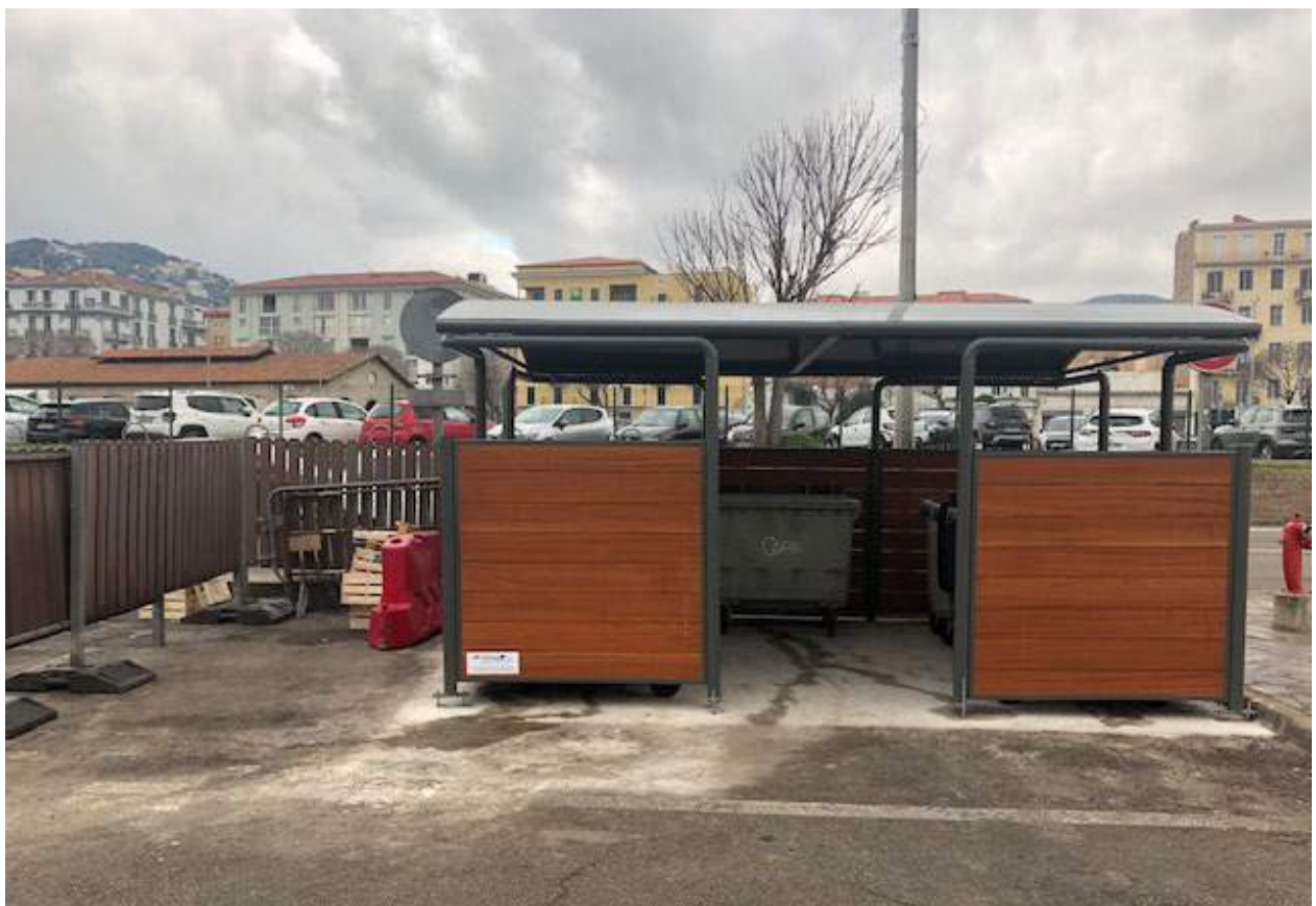
Le pensiline per container installate nel porto Charles Ornano di Ajaccio (FR)
