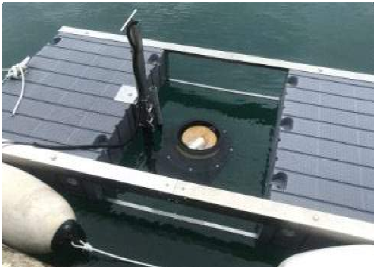
Opérations de livraison des conteneurs "Seabin" à l'Ancienne Darse de Savone et installation à la base du pont Sandro Pertini (côté Torretta).
