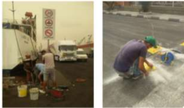
Figura 2: Porto di Tripoli, Libano: interventi per riduzione della velocità
