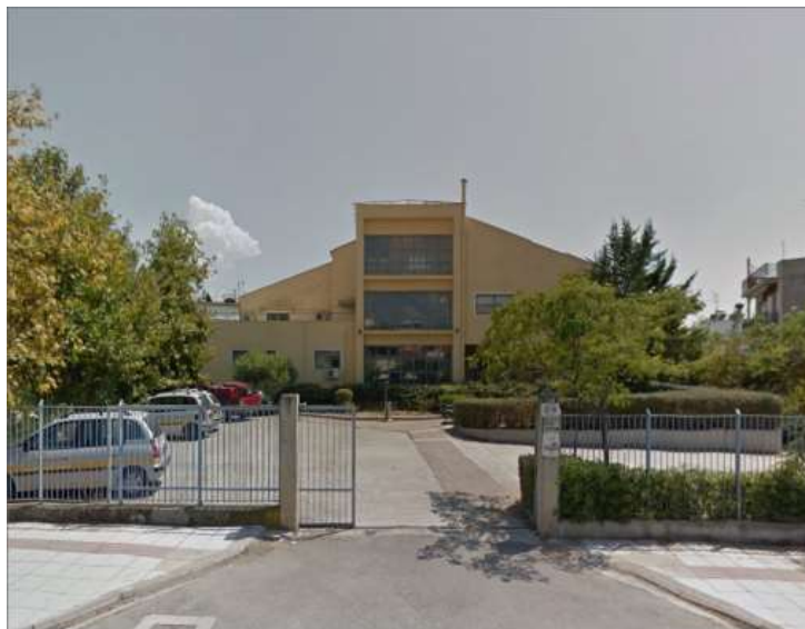
Figura 1: Patrasso: edificio ADEP oggetto di intervento (infissi fonoisolanti)
