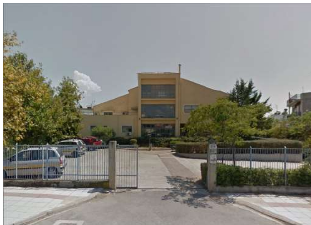
Figura 3 Patrasso - Batiment ADEP- objet d'intervention (fenetres insonorisantes)
