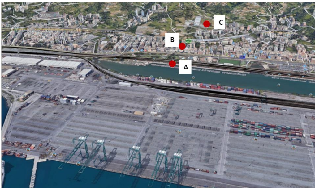
Figure 33 : points de mesure Ligne de contrôle numero1
