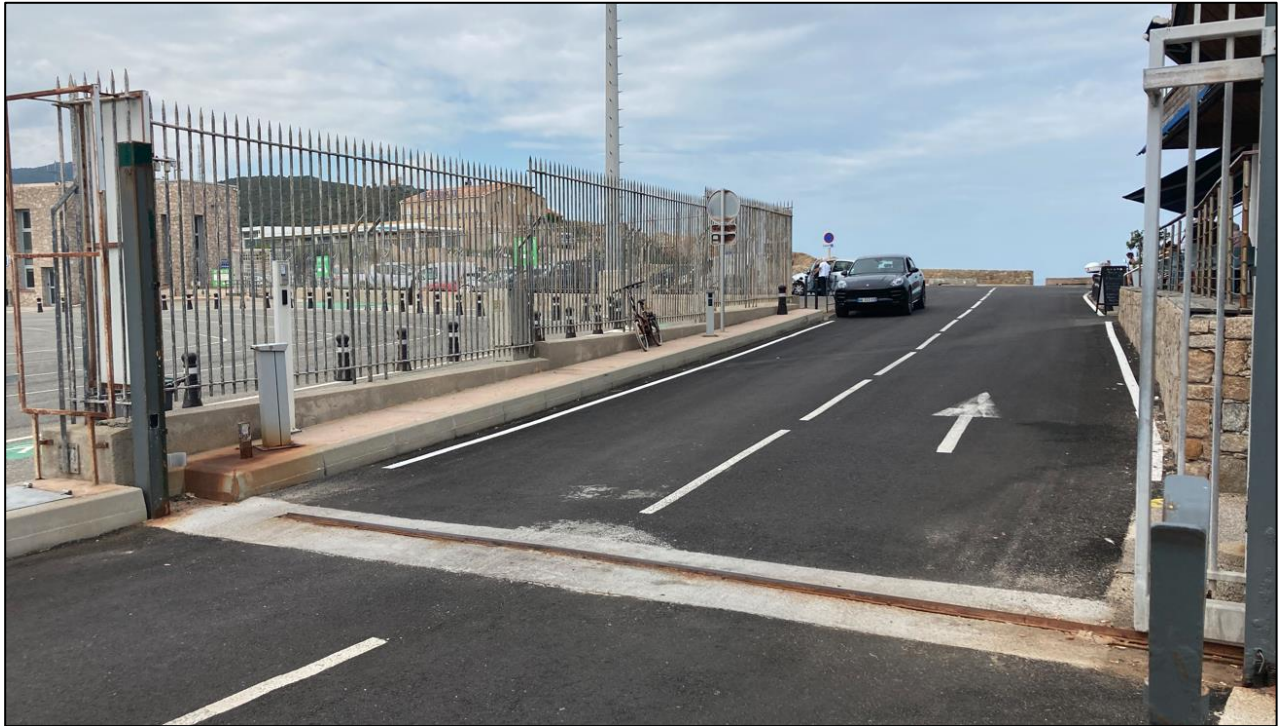
Figure 18: Tronçon 3 – Présence d'un guide métallique en correspondance du portail d'entrée.
