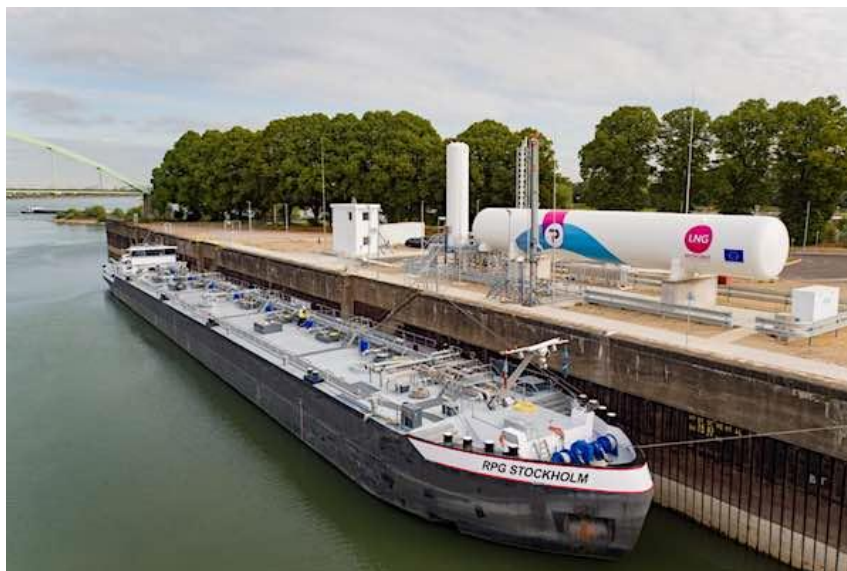
Figure 19 : Photo de la station de soutage dans le port de Cologne
