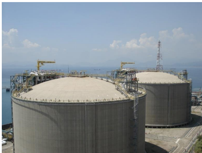
Figure 31 : Photo d'un réservoir aérien à intégrité totale (terminal GNL de Guangdong – Chine)
