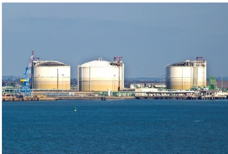
Figure 33 : Photo des réservoirs aériens de type membrane au terminal méthanier de Montoir de Bretagne
