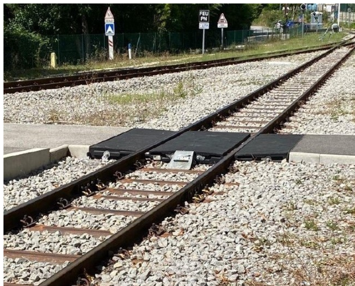
La nuova passerella nella stazione di Touët sur-Var
